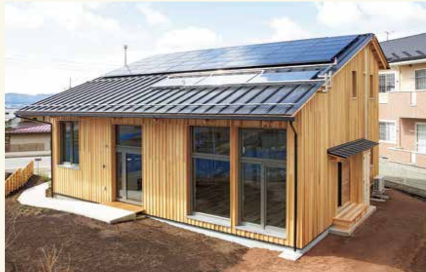
屋根には、太陽光発電、太陽熱温水器、雨水利用などのシステムが取り付けられています
